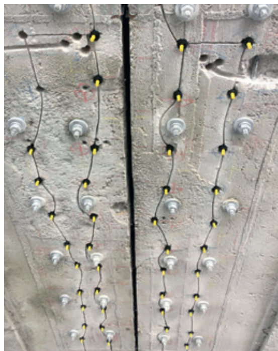
Bild 16: Fertiggestellte Ertüchtigung an den Scheitelgelenken inkl. KKS-System
