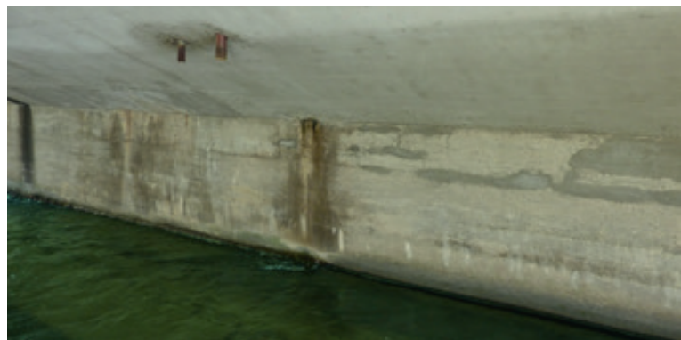
Bild 7: Feuchteschäden an einem Kämpfergelenk
