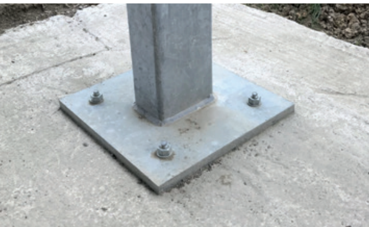
Abbildung 1: typischer Fußpunktanschluss eines Geländers
