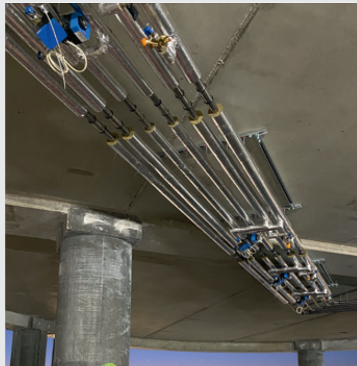
Eingebaute TGA-Module
