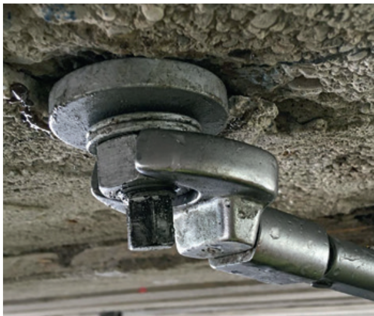
Bild 14: Montage der Verbundankerschrauben Würth RELAST 22 an der Brückenunterseite
