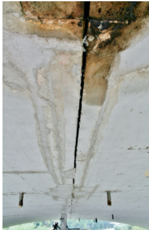
Bild 6: Durchfeuchtungen an den Scheitelgelenken
