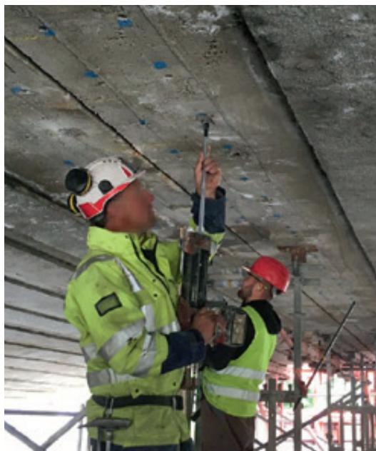
Bild 13: Herstellen der Bohrlöcher für die Verbundankerschrauben
