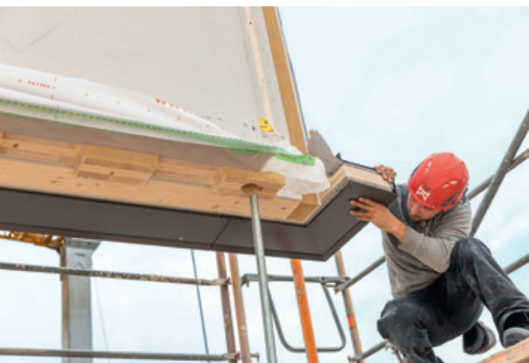
Einführung des Wandelements in die Würth Gewindestangen
