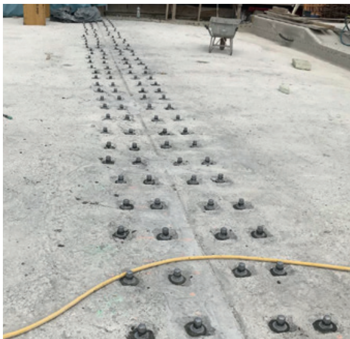
Bild 15: Montage der Verbundankerschrauben Würth RELAST 22 an der Brückenoberseite
