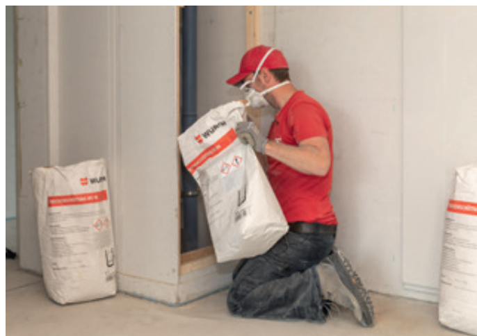
Einbringen der Trockenschüttung
