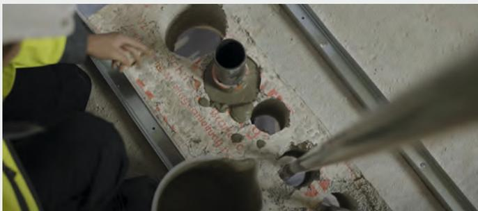
Umlaufende Restspalt am Rohr mittels Würth Brandschutzmörtel verschließen
