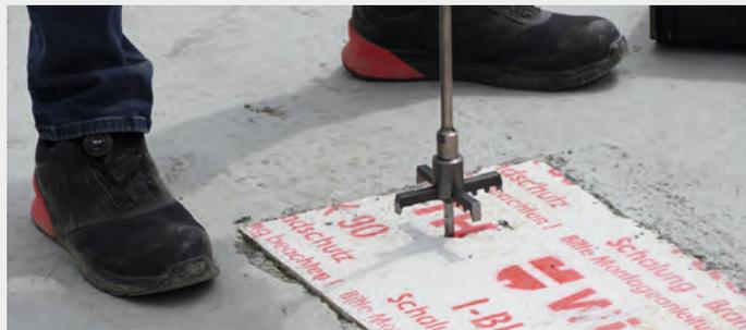
Durch Kernbohrungen mit dem Leichtbetonfräser passgenaue Öffnungen für das Leitungsnetz herstellen
