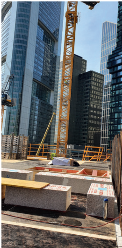
Richtige Positionierung des I-Block 90® vor dem Betonieren
