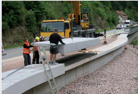
**Die Firma Würth stellt Ihnen das passende Montage-material, wie z.B. Kappenanker, für Ihr Brückenbau-Projekt zur Verfügung.**
