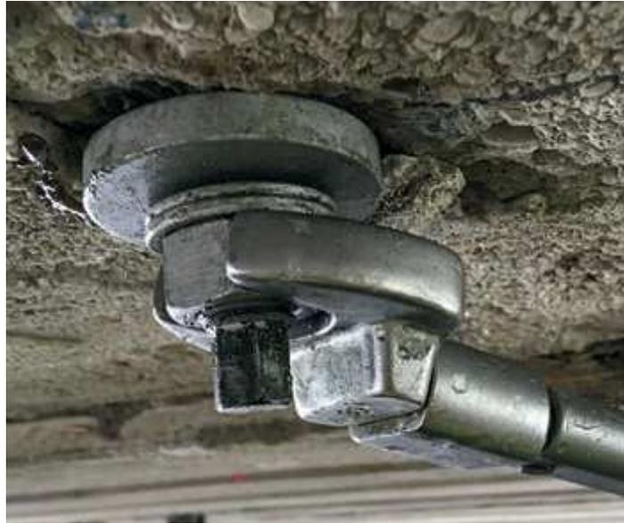
**Bild 14:** Montage der Verbundankerschrauben Würth RELAST 22 an der Brückenunterseite
