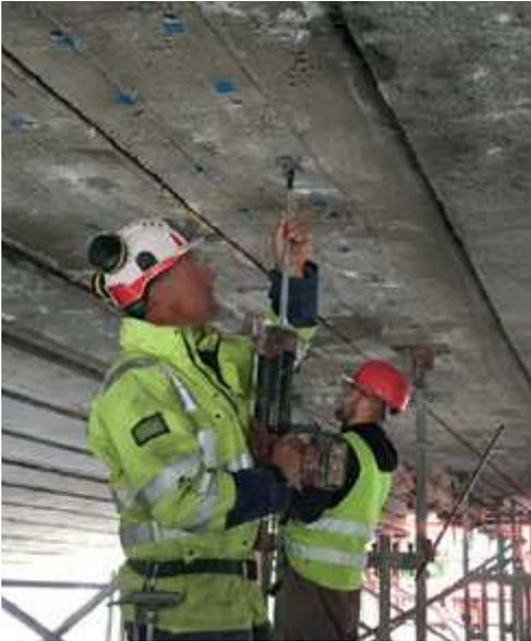
**Bild 13:** Herstellen der Bohrlöcher für die Verbundankerschrauben
