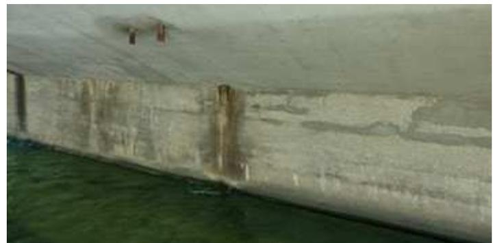
**Bild 7:** Feuchteschäden an einem Kämpfergelenk
