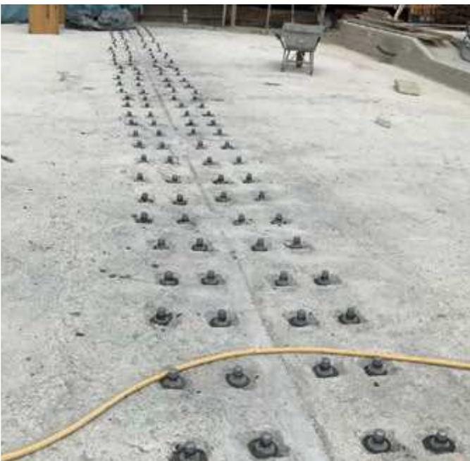
**Bild 15:** Montage der Verbundankerschrauben Würth RELAST 22 an der Brückenoberseite
