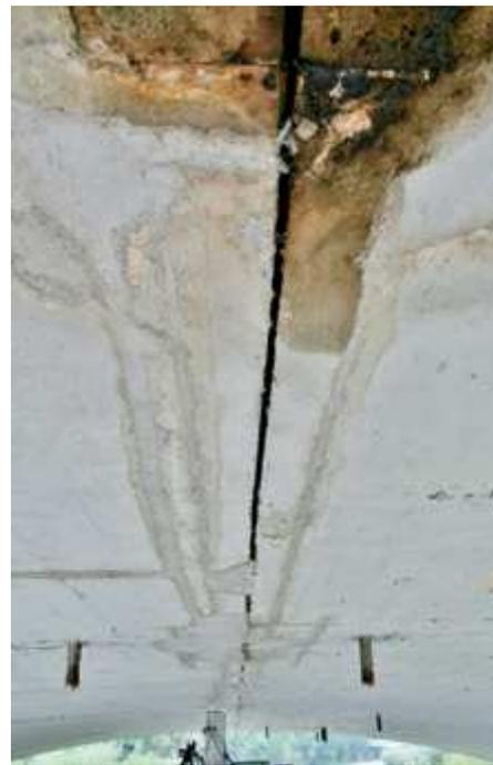
**Bild 6:** Durchfeuchtungen an den Scheitelgelenken
