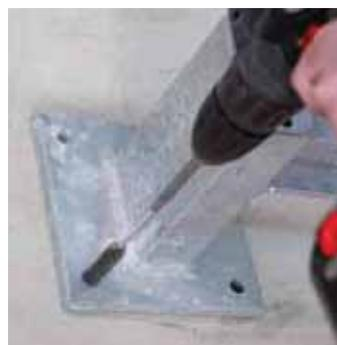
Bohrloch reinigen, zweimal maschinell ausbürsten
