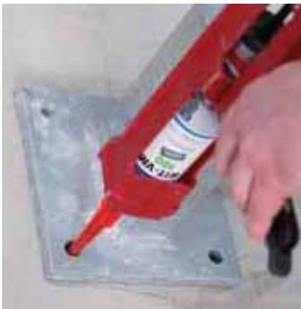
Bohrlochgrund mit Verbundmörtel ausfüllen
