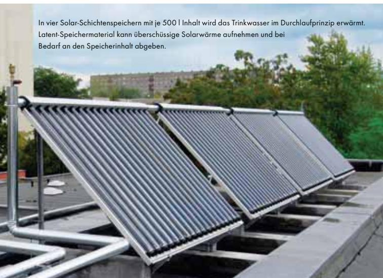
dach über eine Wanddurchdringung zu den Solar-Schichtenspeichern im Keller des Gebäudes, die im Tichelmannsystem angeschlossen wurden.
