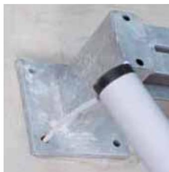
Bohrloch reinigen, zweimal ausblasen
