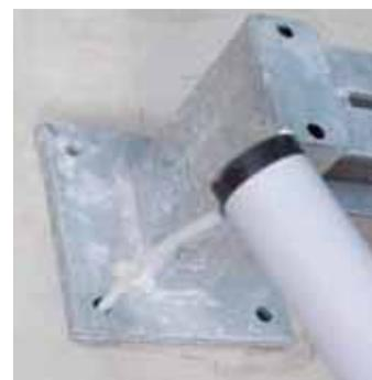
Bohrloch reinigen, zweimal ausblasen
