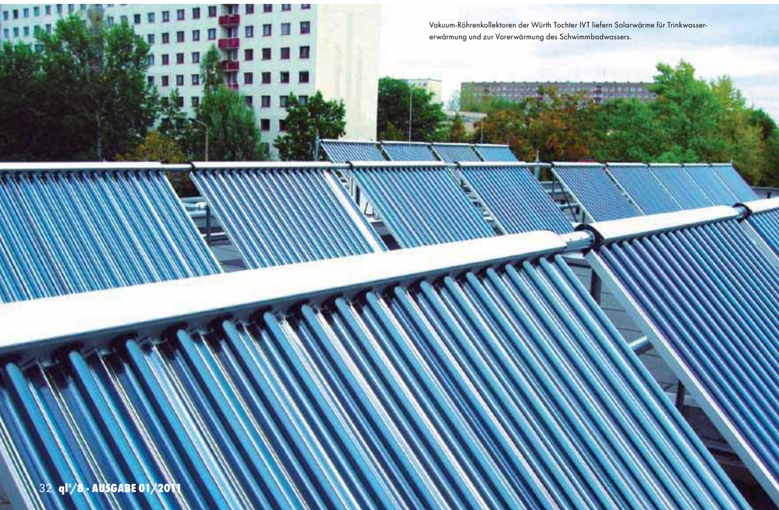
Vakuum-Röhrenkollektoren der Würth Tochter IVT liefern Solarwärme für Trinkwassererwärmung und zur Vorerwärmung des Schwimmbadwassers.
