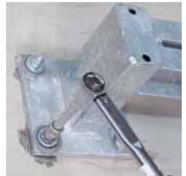
Sicherungsmutter aufschrauben, Montagedrehmoment aufbringen
