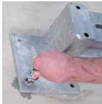
Ankerstange unter leichter Drehbewegung bis zum Bohrlochgrund eindrücken
