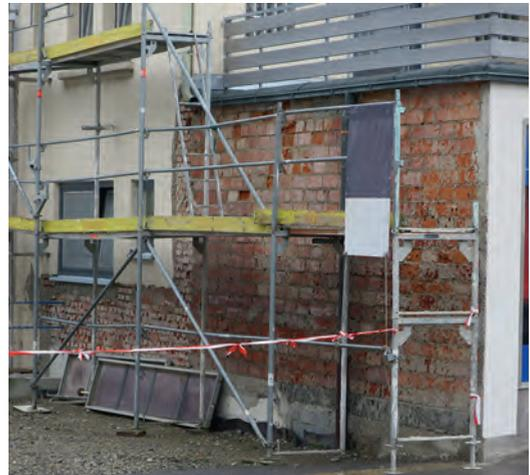
**Bild 17.** Unterschiedliches Mauerwerk in zwei unterschiedlichen Bauabschnitten (Foto: Küenzlen)
