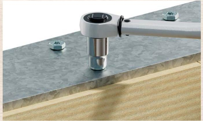
In Stahl-Holz-Verbindungen müssen die Schrauben mit definiertem Drehmoment angezogen werden.
